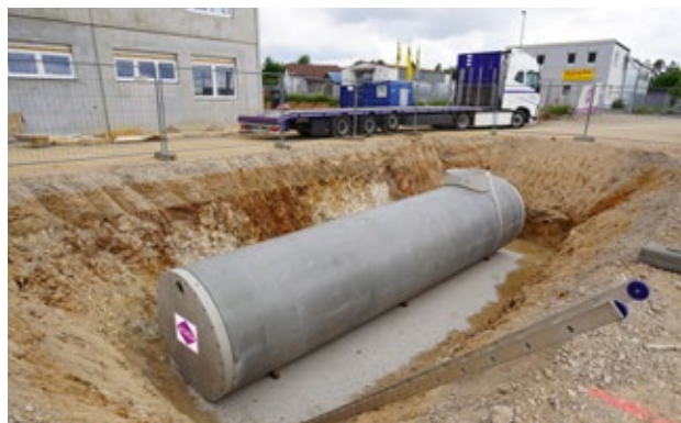
Die FUCHS HPC Tube ist mit einem Hub in der Baugrube
